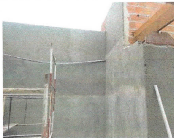
Revestimento, reboco de interior sobre paredes, pavimento superior, sala Administrativo.
