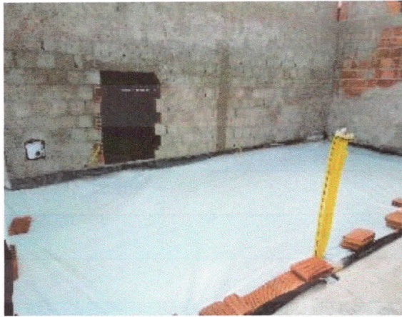
Pavimentação, enchimento de rebaixo existente, 15cm. pavimento superior, sala administrativo, isolamento com lona plástica dupla face.
