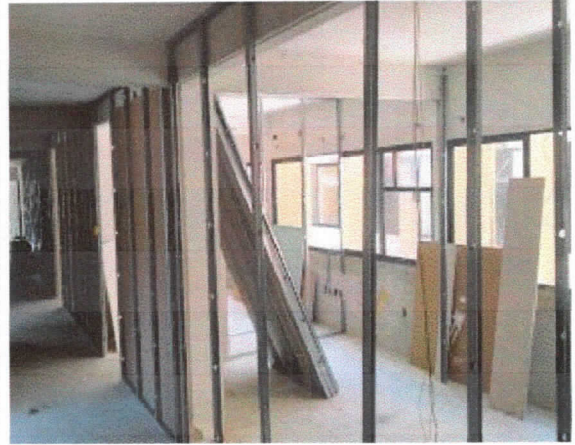
Elevações, montagem de paredes tipo drywall, gabinetes.
