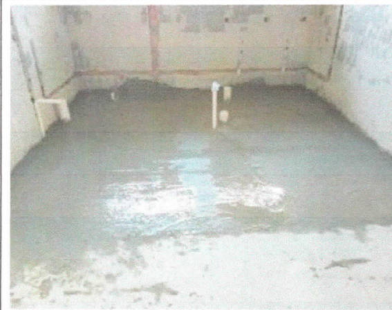
Pisos, regularização de contra piso decorrente de demolição de piso cerâmico, banheiro PCD feminino, térreo.
