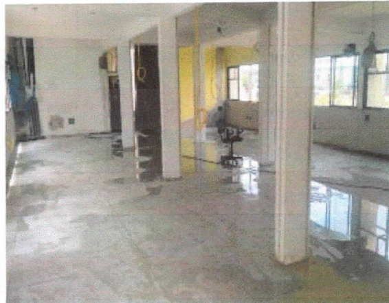
Polimento de piso de alta resistência existente, área de gabinetes, finalizado.
