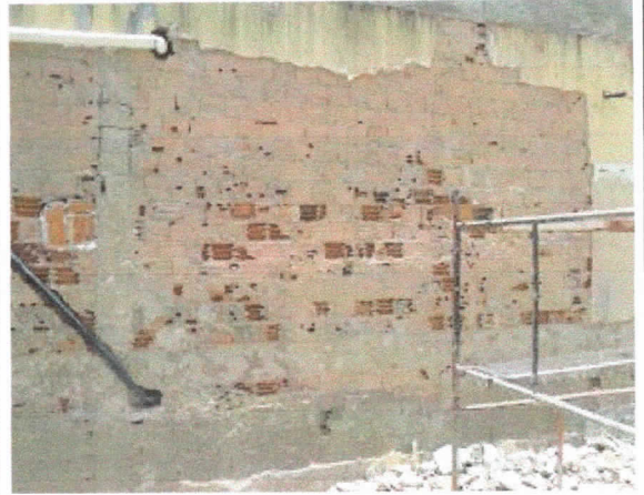
Revestimento, demolição de reboco existente de parede externa do plenário, sala de recepção.
