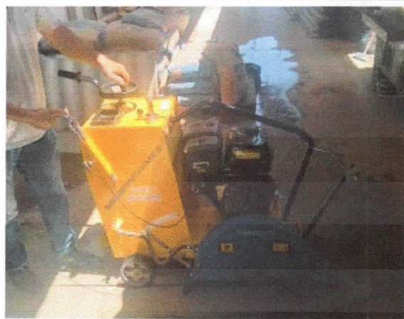
Corte mecanizado de piso de concreto simples, e= 10cm. Para instalação de rede de esgoto sanitário, área da cozinha e refeitório.
