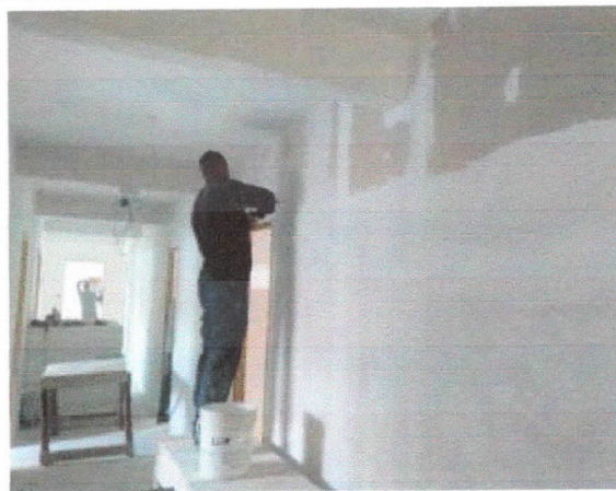
Pintura, emassamento de paredes, circulação gabinetes.
