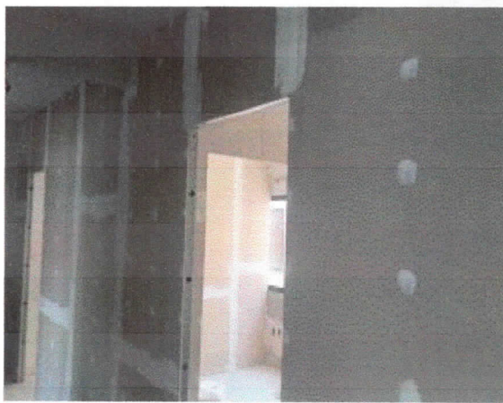
Elevações, montagem de paredes tipo drywall, gabinetes.
