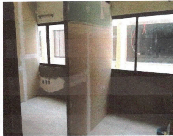
Elevações, montagem de paredes tipo drywall, gabinetes.
