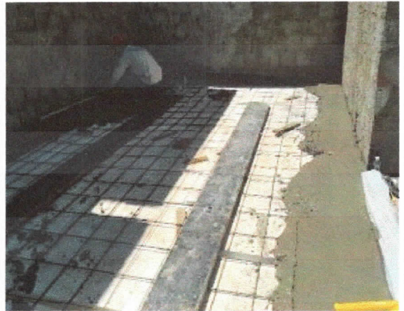
Pavimentação, enchimento de rebaixo existente, 15cm. pavimento superior, sala administrativo, execução de proteção mecânica de concreto armado, e= 5cm.
