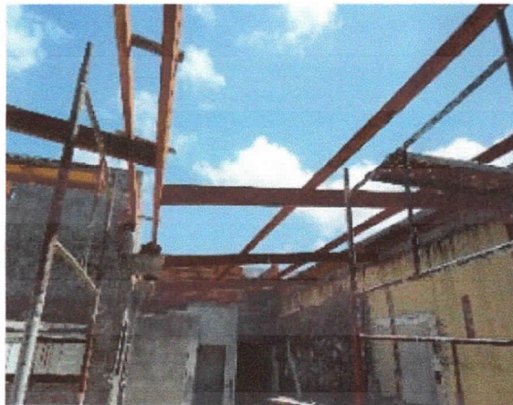
Cobertura, montagem de estrutura de madeira de sustentação do telhado pavimento superior.
