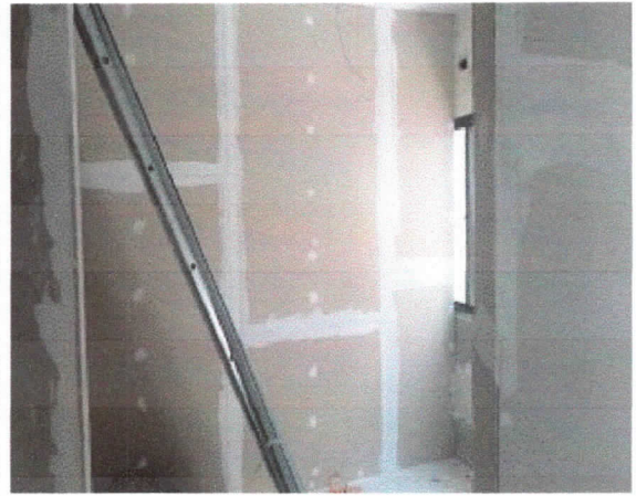
Elevações, montagem de paredes tipo drywall, gabinetes.
