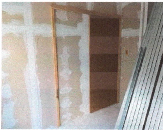
Esquadrias, porta semi-ôca, de correr, instalada, gabinetes.
