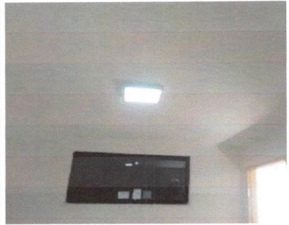
Elétrica, instalação de luminária sobrepor tipo led, refeitório.
