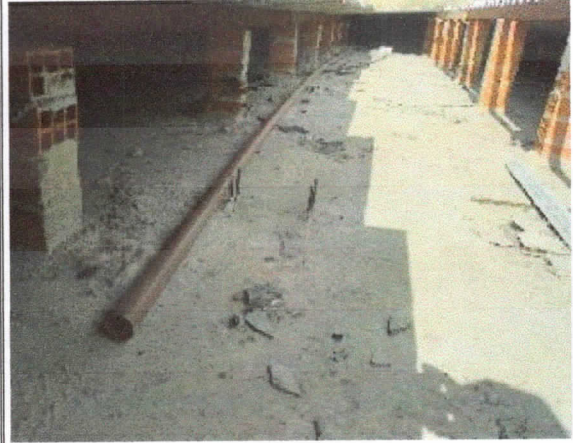
Hidráulica, instalação de tubulação 50mm pvc soldável, abastecimento banheiros gabinetes e cozinha, térreo.
