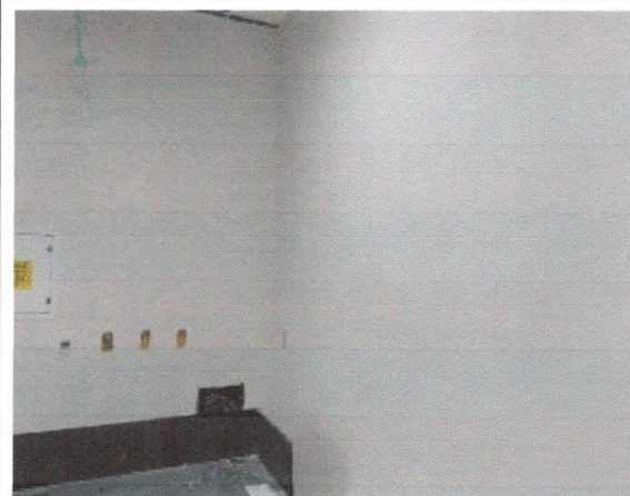
Pintura, sala de áudio e vídeo plenário, finalizado.
