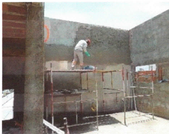
Revestimento, reboco de interior sobre paredes, pavimento superior, sala diretoria escola legislativo.
