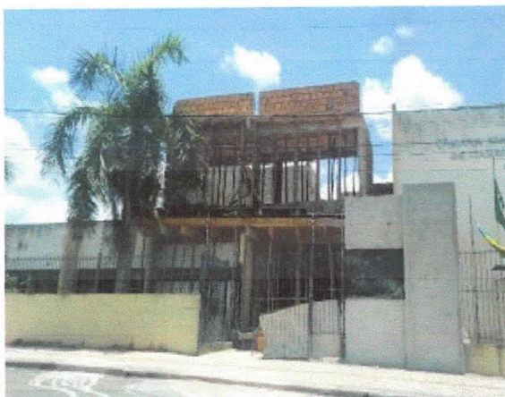
Cobertura, execução de alvenaria de platibanda, pavimento superior.
