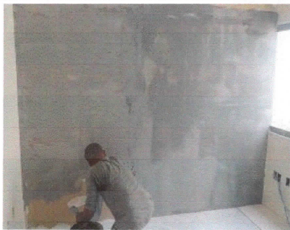
Pintura, emassamento para tinta cimentícia de paredes, gabinetes.
