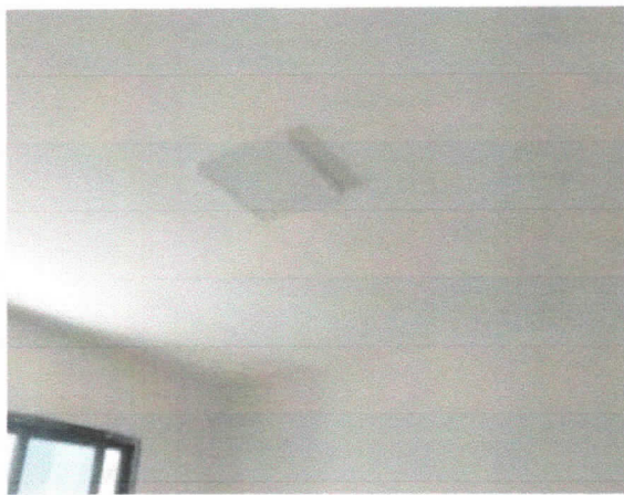
Elétrica, instalação de luminária sobrepor tipo led, cozinha.
