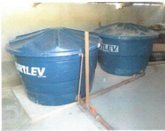
Hidráulica, instalação de caixa d'água 100l. abastecimento pavimento térreo.
