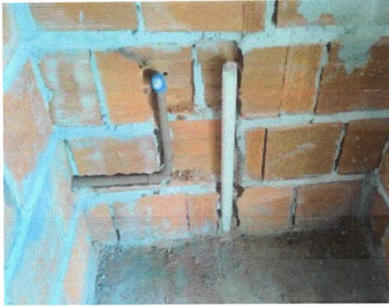
Hidráulica, instalação de tubulação 25mm pvc soldável, abastecimento lavabo feminino, térreo.
