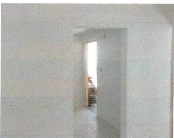
Revestimento, aplicação de revestimento cerâmico da cozinha, finalizado.
