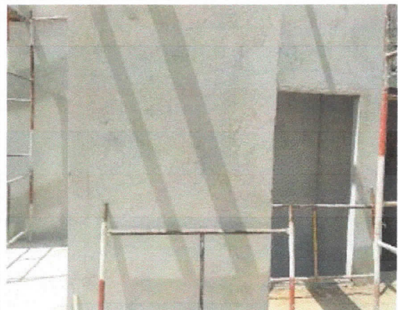
Revestimento, reboco de interior, acesso ao lavabo e banheiro superior, finalizado.
