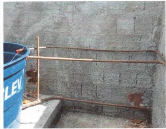
Hidráulica, instalação de linha de abastecimento tubo pvc soldável 20mm, pavimento superior.
