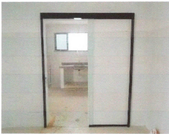
Esquadrias, portas de vidro temperado 10mm, de correr, instalada passagem refeitório e cozinha.
