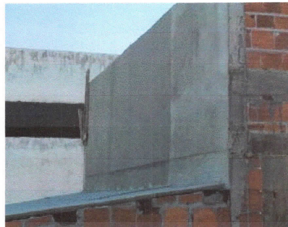
Revestimento, reboco de exterior sobre paredes.
