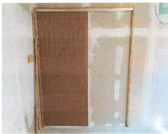
Esquadrias, porta semi-ôca, de correr, instalada, gabinetes.
