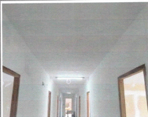
Pintura, emassamento de teto e paredes, circulação gabinetes, finalizado.
