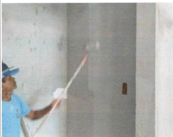
Pintura, aplicação de demão de tinta PVA látex sobre parede, sala de áudio e vídeo, plenário.
