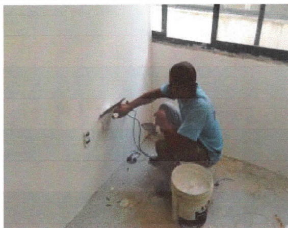
Pintura, emassamento de paredes, gabinetes.
