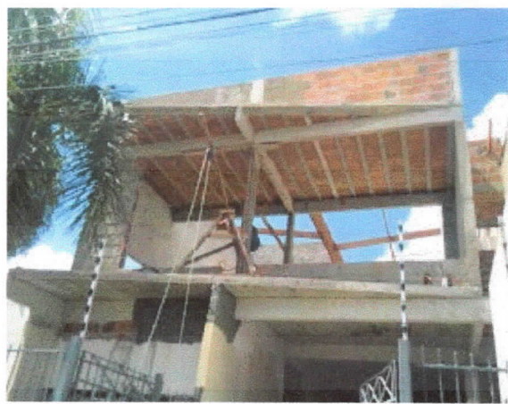
Estrutura, lajes e vigas, desforma finalizada.
