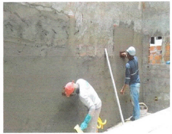
Revestimento, reboco de interior sobre paredes, pavimento superior, sala diretoria escola legislativo.
