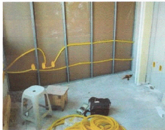
Elétrica, instalação de caixas de tomadas, gabinetes, térreo.
