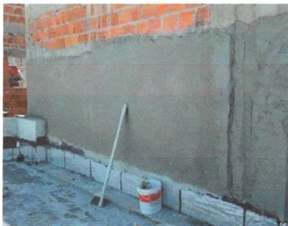
Revestimento, reboco de exterior sobre paredes.
