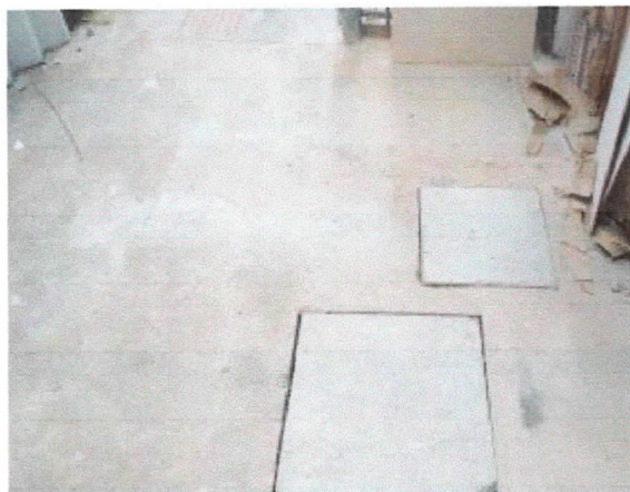
Climatização, rasgos mecanizados em parede exterior para embuti mento de tubulação de gás, comando e dreno, plenário.
