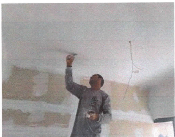
Pintura, emassamento de teto, gabinetes.
