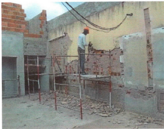
Revestimento, demolição de reboco existente de parede externa do plenário, sala de recepção.
