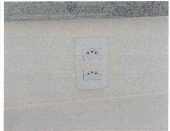
Elétrica, instalação de tomada dupla 10A, cozinha.
