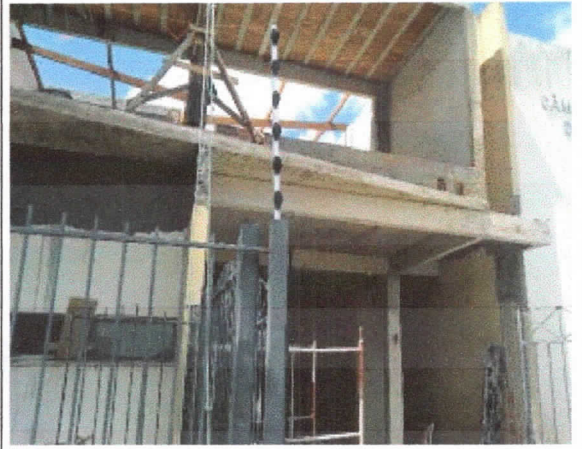
Estrutura, lajes e vigas, desforma finalizada.
