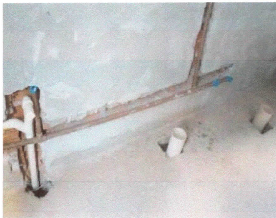
Esgoto, pontos de esgoto e água, vaso sanitário, lavatório, caixa sifonada banheiro superior.
