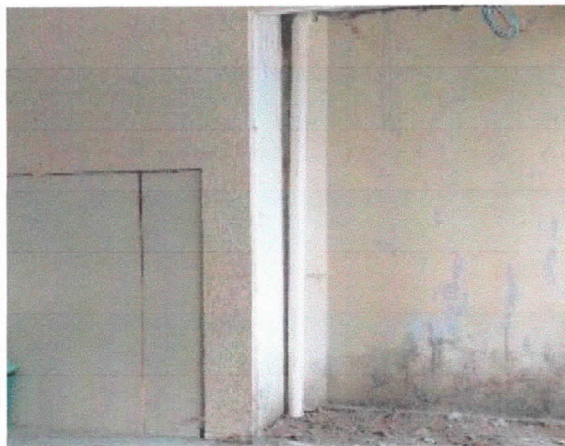
Esgoto, tubo de queda, banheiro presidência, superior
