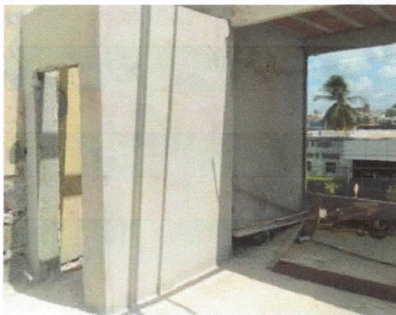
Revestimento, reboco de interior banheiro sala do presidente, finalizado.
