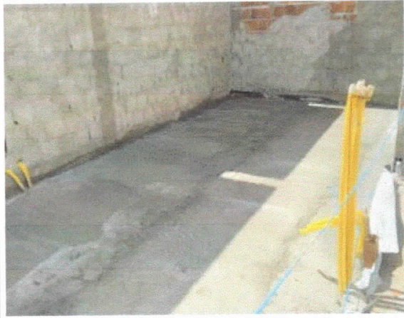
Pavimentação, enchimento de rebaixo existente, 15cm. pavimento superior, sala administrativo, finalizado.
