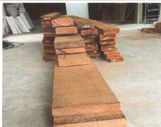
Coberturas, madeira de lei tipo Massaranduba para execução do telhado pavimento superior.
