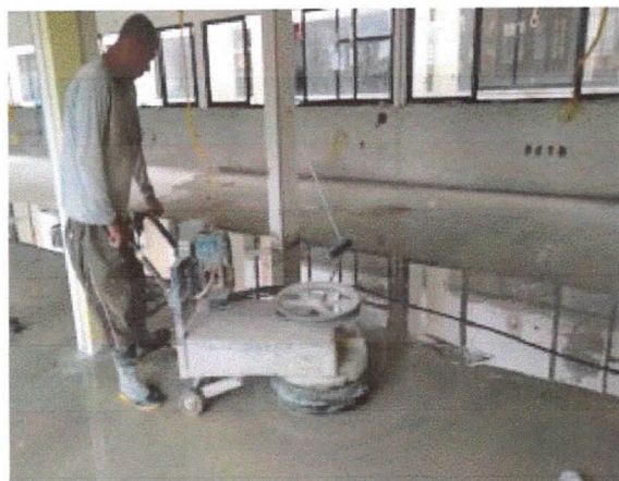
Polimento de piso de alta resistência existente, área de gabinetes.
