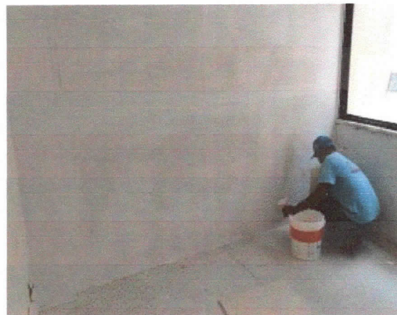
Pintura, emassamento de paredes, gabinetes.
