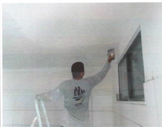
Pintura, emassamento de teto, refeitório.
