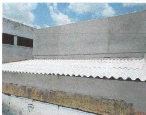
Coberturas, telhado fibrocimento 6mm sobre caixas d'água de abastecimento do térreo.
