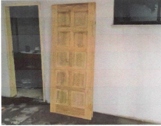
Esquadrias, portas maciças em madeira de lei, 8 almofadas, para instalação, cozinha e refeitório.
