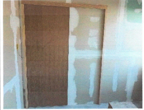
Esquadrias, porta semi-ôca, de correr, instalada, gabinetes.
