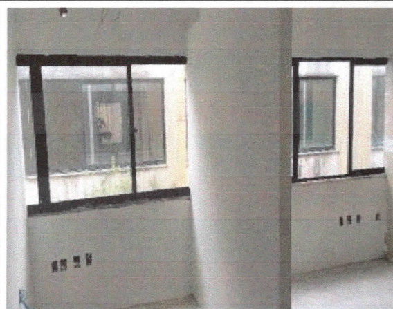
Pintura, emassamento de teto e paredes, gabinetes, finalizado.
