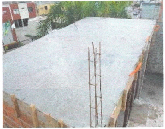
Estrutura, concretagem de laje pré-moldada finalizada, cobertura superior
