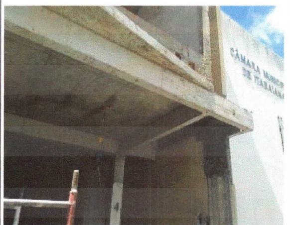
Estrutura, lajes e vigas, desforma finalizada.
