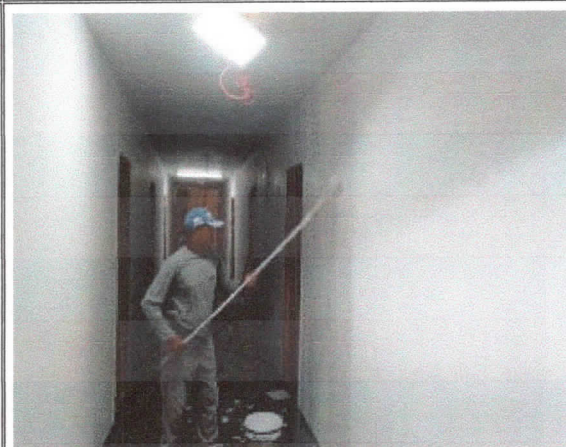
Pintura, aplicação de demão de tinta PVA látex sobre parede, circulação gabinetes.
