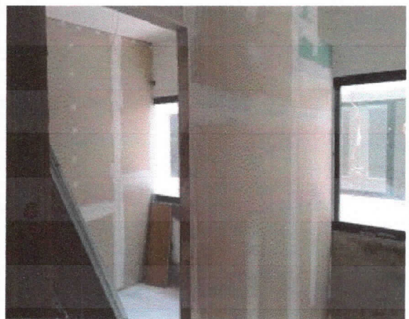
Elevações, montagem de paredes tipo drywall, gabinetes.
