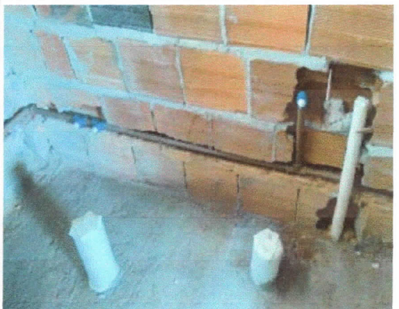
Hidráulica, instalação de tubulação 25mm pvc soldável, abastecimento banheiro PCD feminino, térreo.
