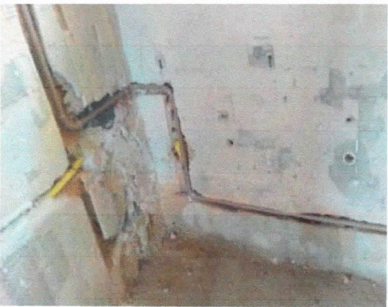
Hidráulica, instalação de tubulação 25mm pvc soldável, abastecimento banheiro feminino, térreo.
