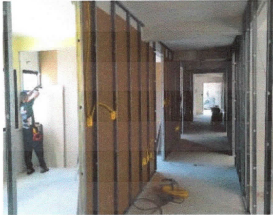
Elevações, montagem de paredes tipo drywall, gabinetes.
