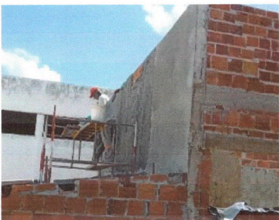
Revestimento, reboco de exterior sobre paredes.
