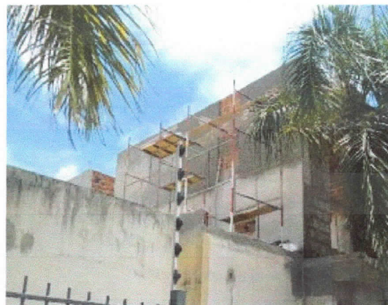
Revestimento, reboco de exterior sobre paredes.
