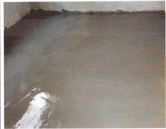
Pisos, regularização de contra piso decorrente de demolição de piso cerâmico, banheiro PCD masculino, térreo.
