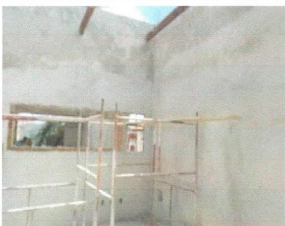
Revestimento, reboco de interior, administrativo, superior finalizado.
