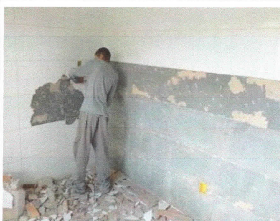
Revestimento, demolição de revestimento cerâmico da cozinha existente.
