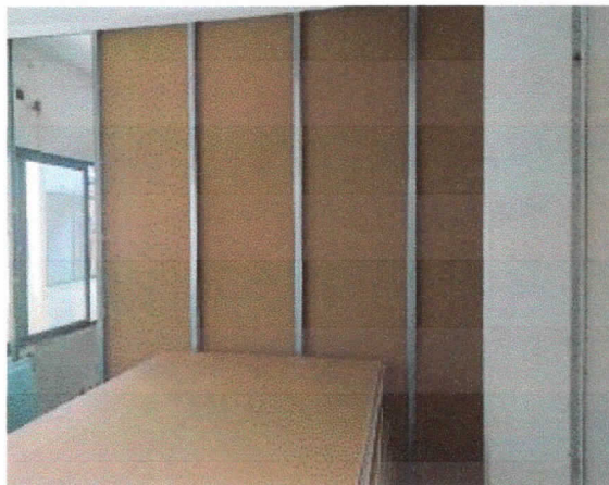
Elevações, montagem de paredes tipo drywall, gabinetes.
