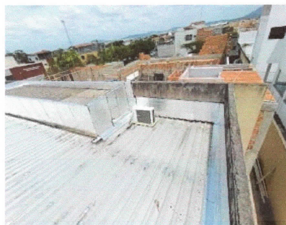
Coberturas, revestimento de calha de chapa de zinco com manta de alumínio a quente, cobertura do plenário.
