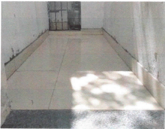
Piso cerâmico tipo porcelanato instalado, casa de gás.
