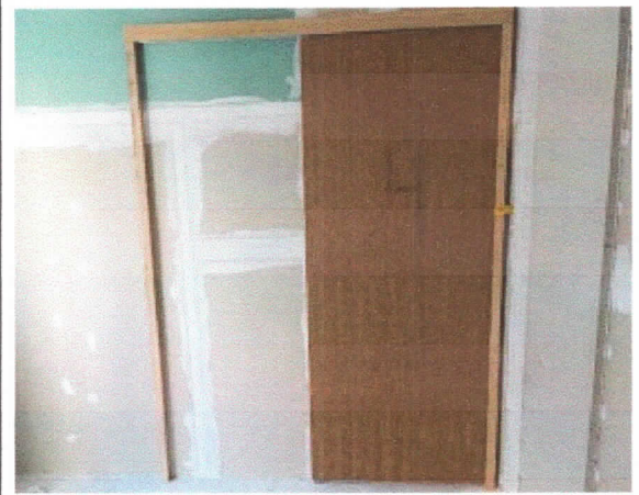
Esquadrias, porta semi-ôca, de correr, instalada, gabinetes.
