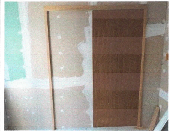
Esquadrias, porta semi-ôca, de correr, instalada, gabinetes.
