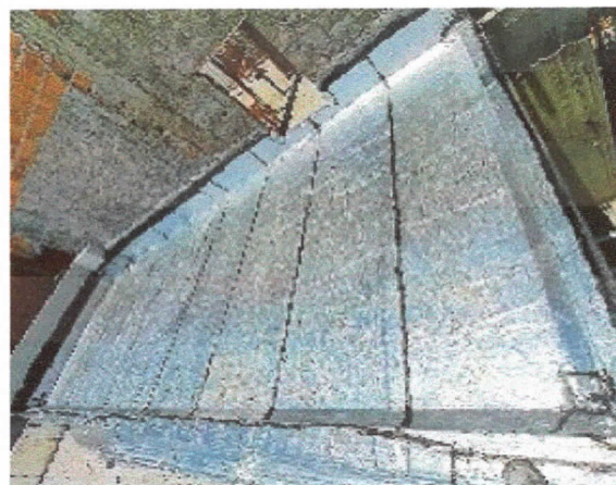
Coberturas, revestimento de laje existente com manta de alumínio a quente, cobertura do térreo banheiros PCD.
