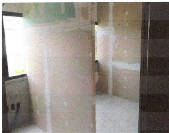
Elevações, montagem de paredes tipo drywall, gabinetes.
