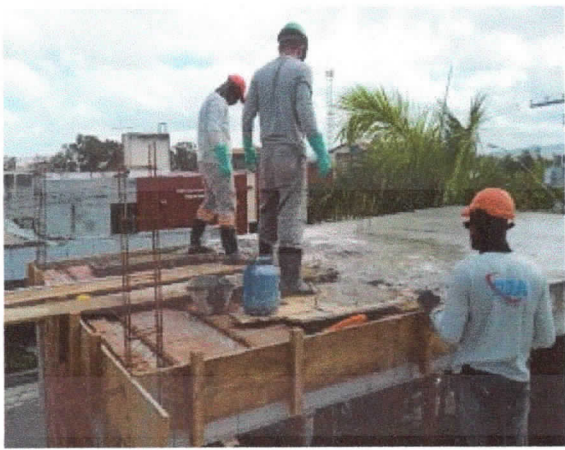
Estrutura, concretagem de laje pré-moldada, cobertura superior
