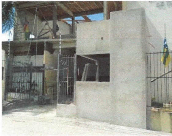
Revestimento, reboco de interior e exterior, guarita, finalizado.
