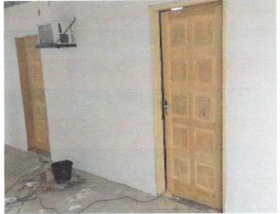
Esquadrias, portas maciças em madeira de lei, 8 almofadas, instaladas, cozinha e refeitório.
