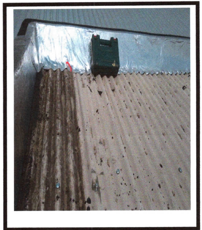
FOTO 24 – Instalação manta
