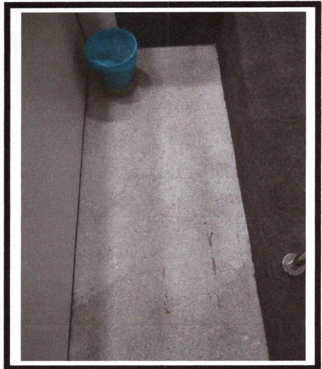
FOTO 34 – Piso de Alta resistência
