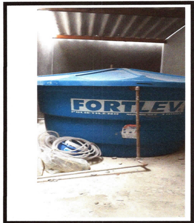
FOTO 12 – Relocação caixa d'água
