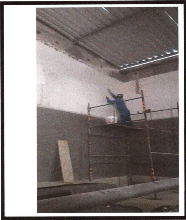
FOTO 29 –Aplicação de massa nas parede
